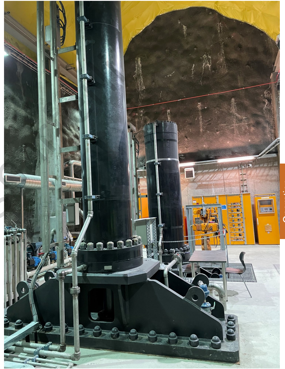
Ljós. 62: Botnrásarloka við Kárahnjúkastíflu.
