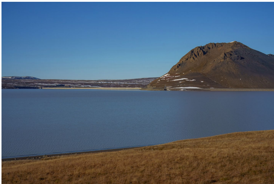
Ljós. 19: Háslón, horft til Kárahnjúka- and Desjarárstíflu
